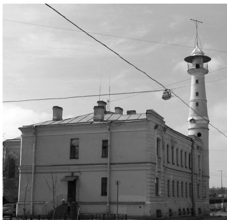
Здание Охтинской общественной богадельни и съезжей части. Позднее в нем размещалась Охтинская пригородная управа. В настоящее время - пожарная часть. Арх. П.П. Меркулов. 1867. Фото. 2000-е
