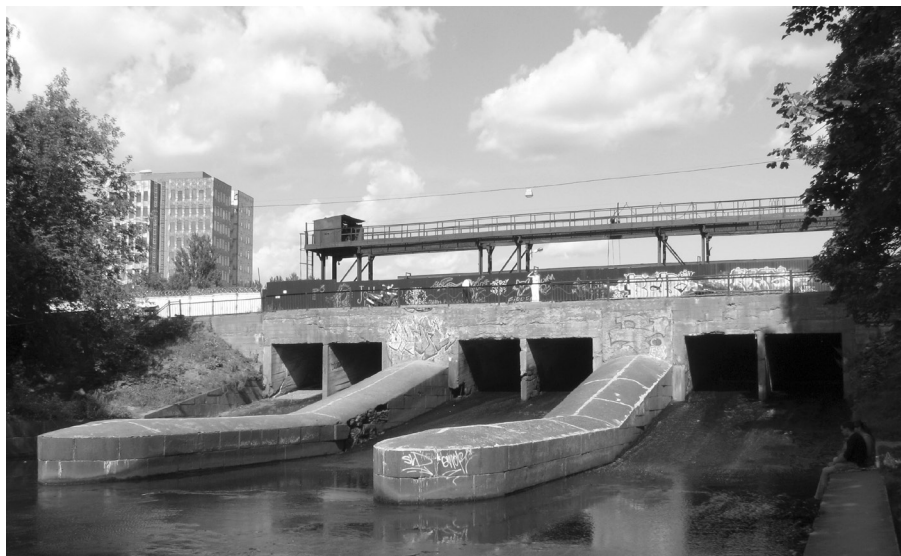
Плотина Охтинского порохового завода. Фото. 2009
