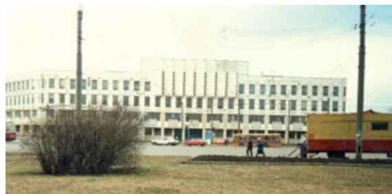
Лабораторно-производственное здание «Петрозавода» Арх. А.В. Васильев, Г.А. Васильев. «ЛенНИИпроект». 1987 Фото Н. Столбовой. 1998
