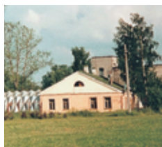
Дом военных поселян на 2-й Жерновской ул. 1837 Фото С. Столбова. 1998
