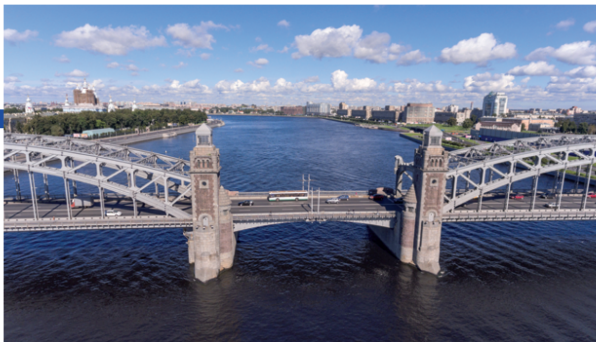
Большеохтинский мост Мост Императора Петра Великого Инж. Г.Г. Кривошеин Арх. В.П. Апышков 1991 Фото А. Кежляйна 2016 Фотобанк «Лори»
