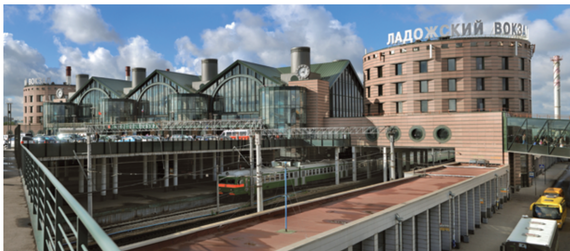
Ладожский вокзал Арх. мастерская Н.И. Явейна. 2003 Фото Д. Яковлева. 2008 Фотобанк «Лори»
