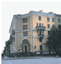
Здание администрации Красногвардейского района 1957. С 1973 – одно из административных зданий аппарата РК КПСС, Исполкома и других служб Красногвардейского района Фото. Н. Столбовой Нач. 2000-х
