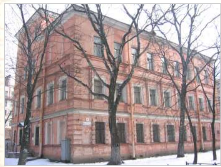
Здание Охтинского детского приюта
